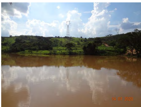
Foto 7 – Ponto P07, Córrego Caracol, parcialmente represado por uma barragem particular. (Data: 14/01/2020).
