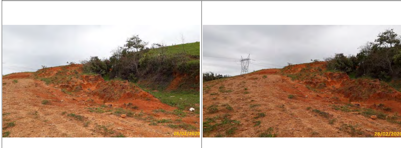
Foto 01 Vista geral das feições erosivas. Foto 02 Detalhe do processo erosivo.
