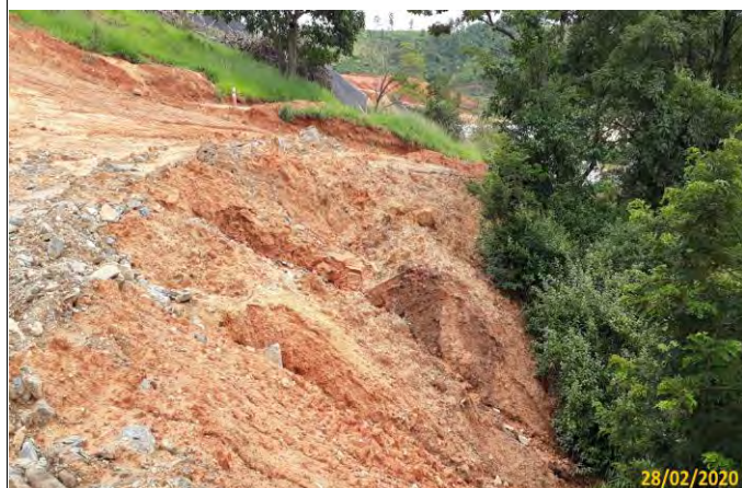
Foto 01 Vista dos sulcos erosivos e talude de corte. Foto 02 Detalhe do processo erosivo no talude.
