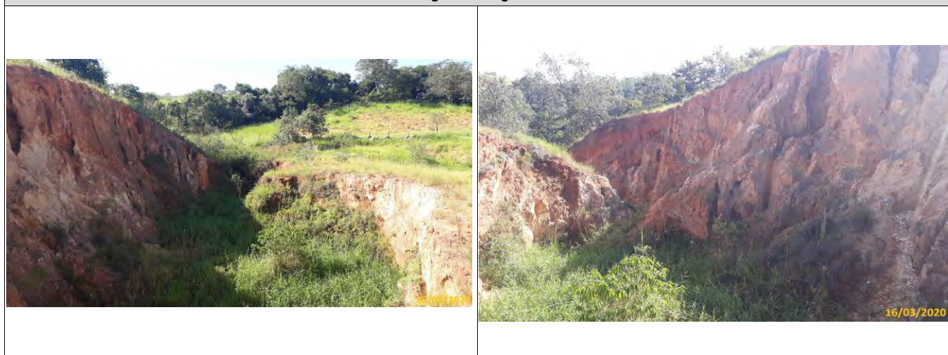
Foto 01 Vista geral da voçoroca. Foto 02 Detalhe da voçoroca.
