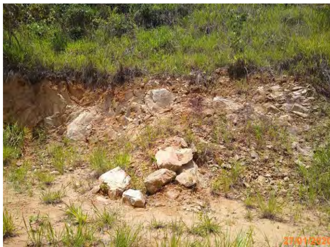
Foto 02 Detalhe do deslocamento rochoso.
