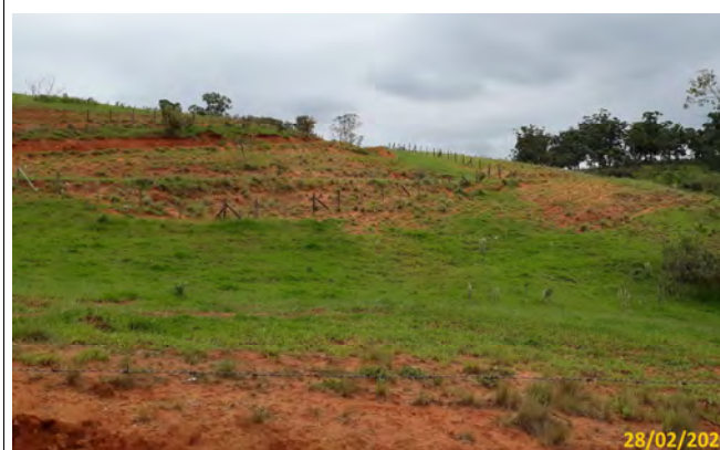
Foto 02 Detalhe do processo erosivo.
