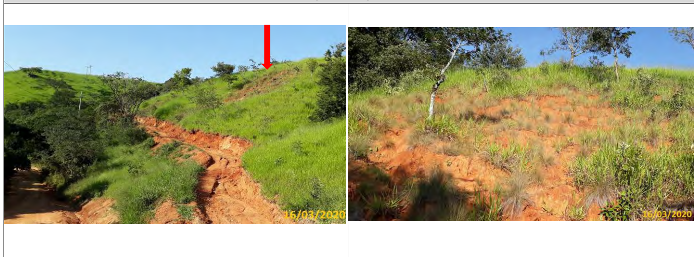
Foto 01 Vista geral das feições erosivas. Foto 02 Detatalhe do processo erosivo.
