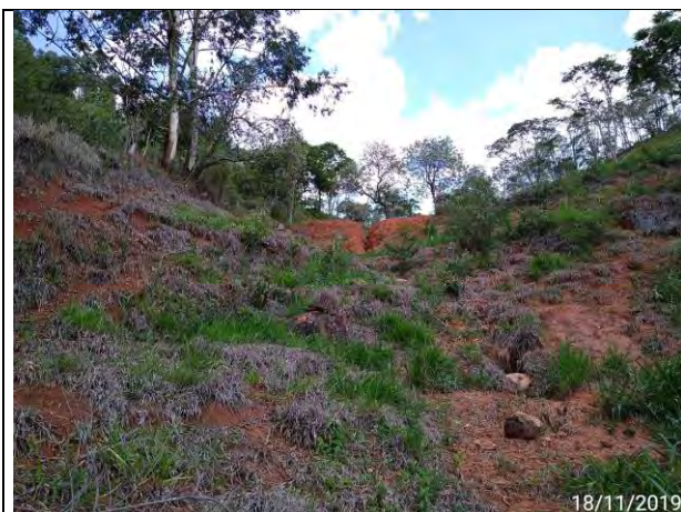
Foto 9- Vista do processo erosivo com formação de sulcos/ravinas.
