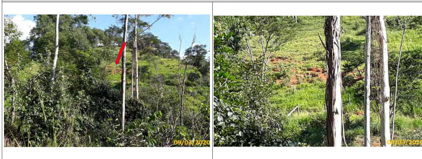
Foto 01 Vista geral do passivo ambiental Foto 02 Detalhe do processo erosivo
