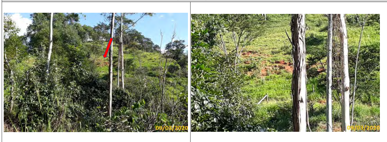
Foto 01 Vista geral do passivo ambiental Foto 02 Detalhe do processo erosivo
