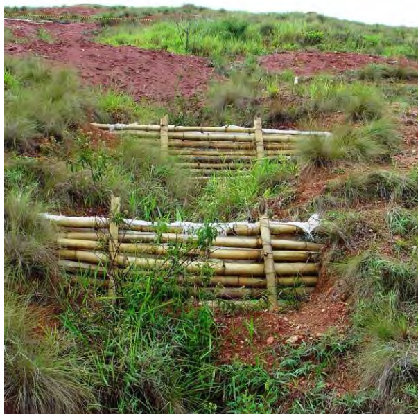
Figura 3 – Exemplo de paliçada com bambu. Fonte: www.embrapa.br , acesso em 16/12/2019.
