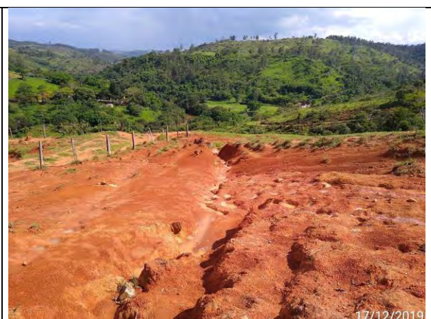
Foto 2 - Detalhe da formação dos sulcos erosivos.
