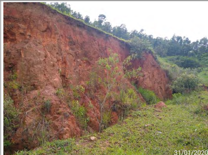
Foto 01 Vista das feições erosivas no talude. Foto 02 Detalhe da ravina/voçoroca..
