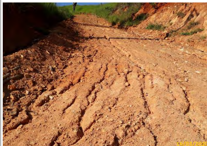
Foto 02 Detalhe dos sulcos no processo erosivo.
