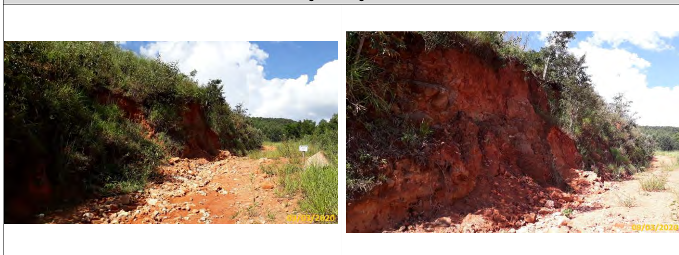
Foto 01 Vista das feições erosivas no talude. Foto 02 Detalhe do processo erosivo.
