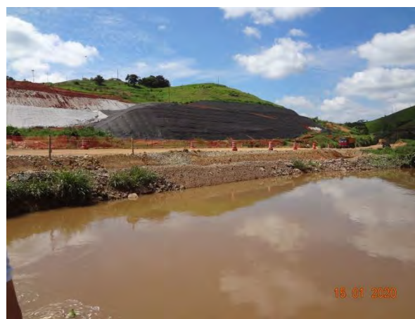
Foto 2 - Ponto P02, Rio Jaguari, próximo ao eixo da Barragem Pedreira. (Data: 15/01/2020).
