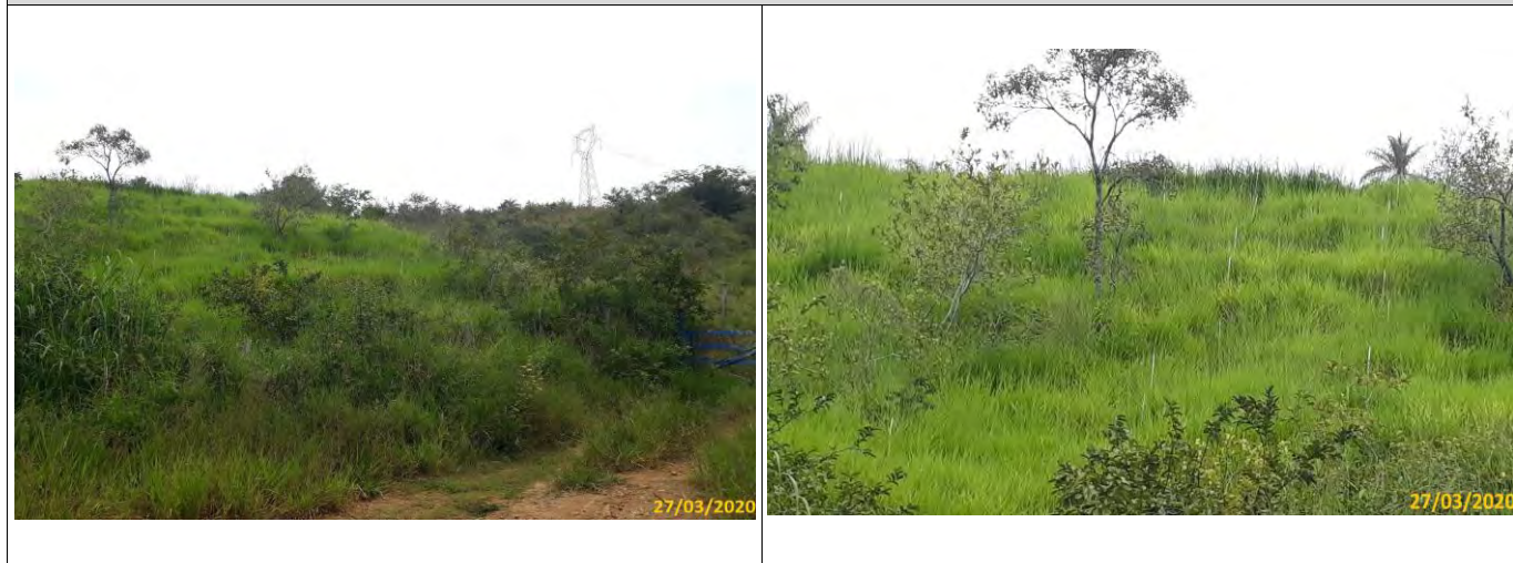
Foto 01 Vista geral da feição erosiva. Foto 02 Detalhe da vegetação plantada.
