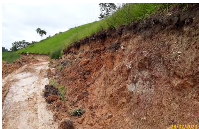
Foto 01 Vista dos sulcos erosivos e talude de corte. Foto 02 Detalhe do processo erosivo no talude.
