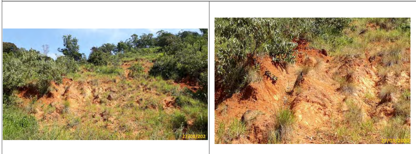
Foto 01 Vista geral da feições erosivas. Foto 02 Detalhe do processo erosivo.
