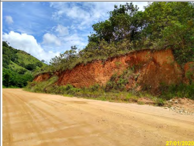
Foto 01 Vista das feições erosivas no talude. Foto 02 Detalhe do deslocamento rochoso/terroso.
