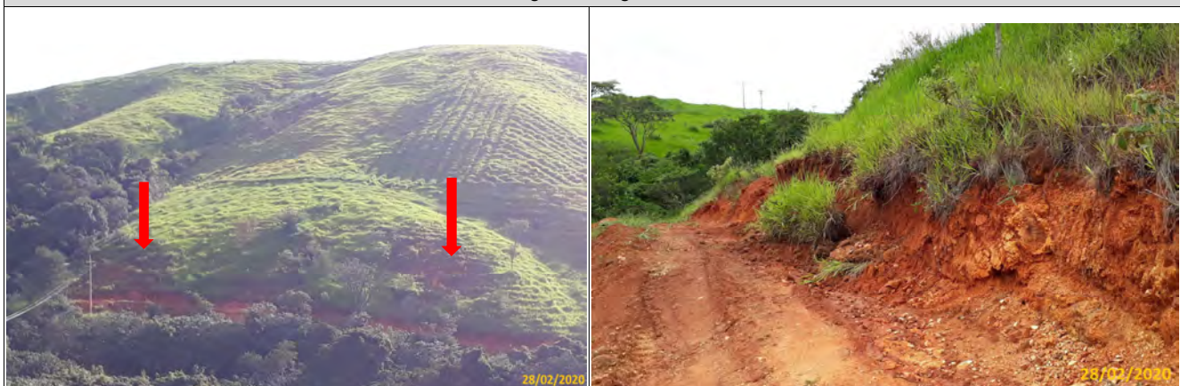
Foto 01 Vista geral das feições erosivas. Foto 02 Detatalhe do processo erosivo.
