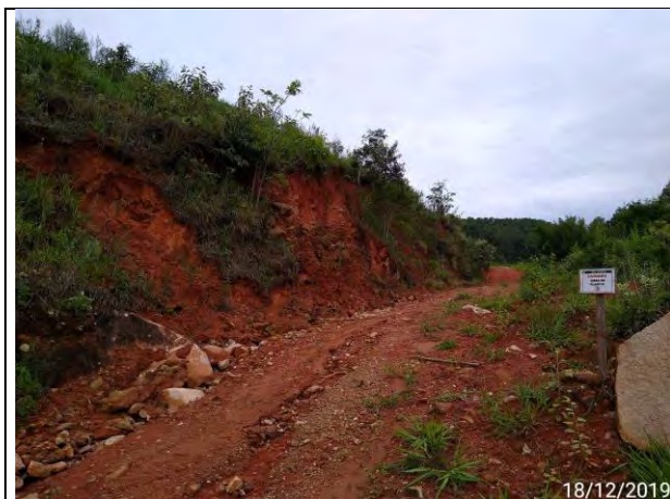
Foto 7 - Vista geral da área com presença de deslocamento do talude.
